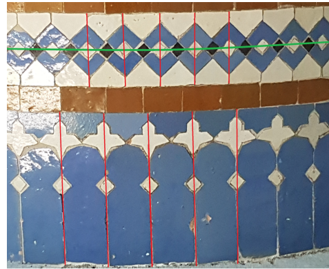
FIGURE 9 – Le pied d'un des pylônes de la terrasse
